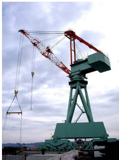
<ジブクレーン>
