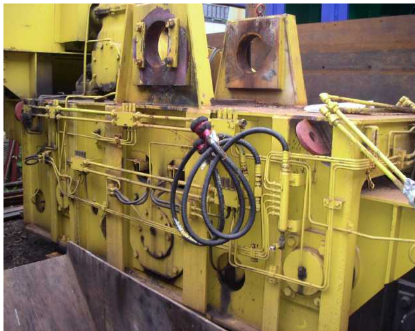
走行駆動部分解整備中
