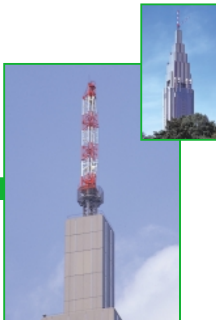
ビルの頂上に設置された当社のデリック
