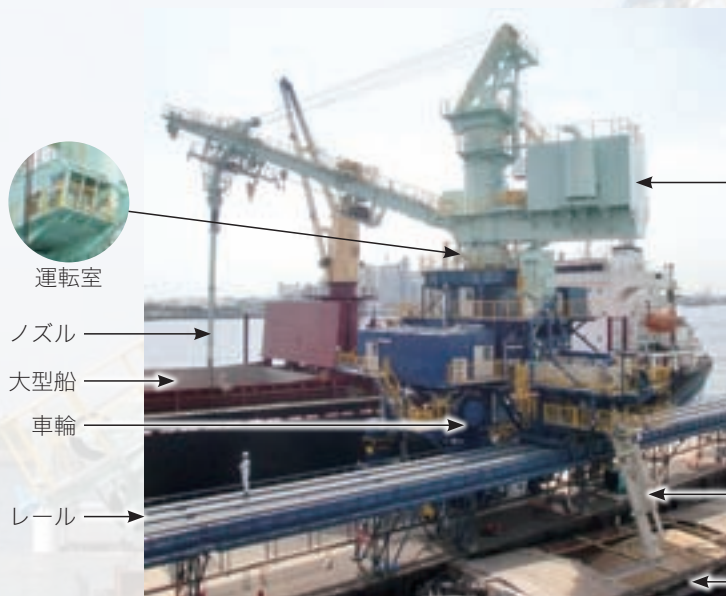
積み込み作業中のニューマチックアンローダ
