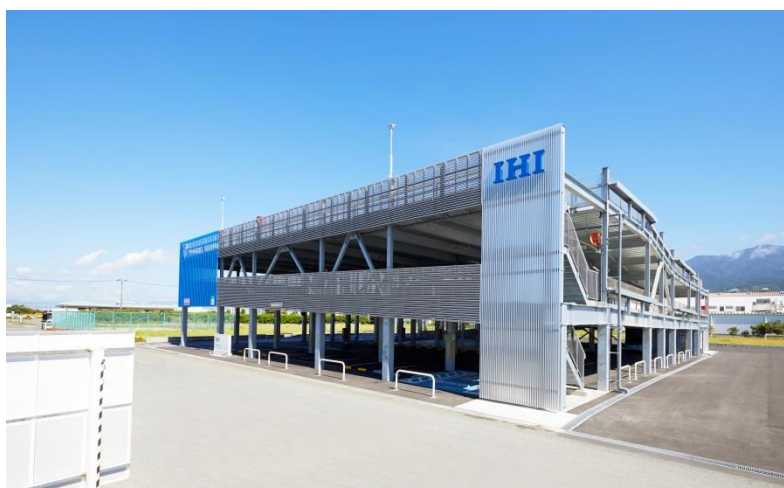
沼津工場敷地内に建設した自走式駐車場設備
