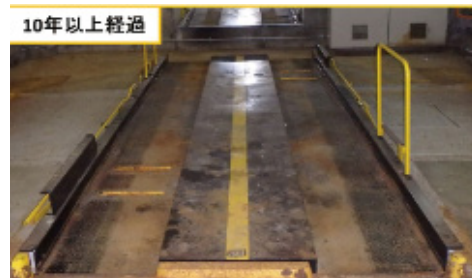
雪国地方の10年経過したパレット写真 (錆付着)
