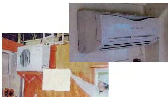
室内を快適にするエアコンの設置
