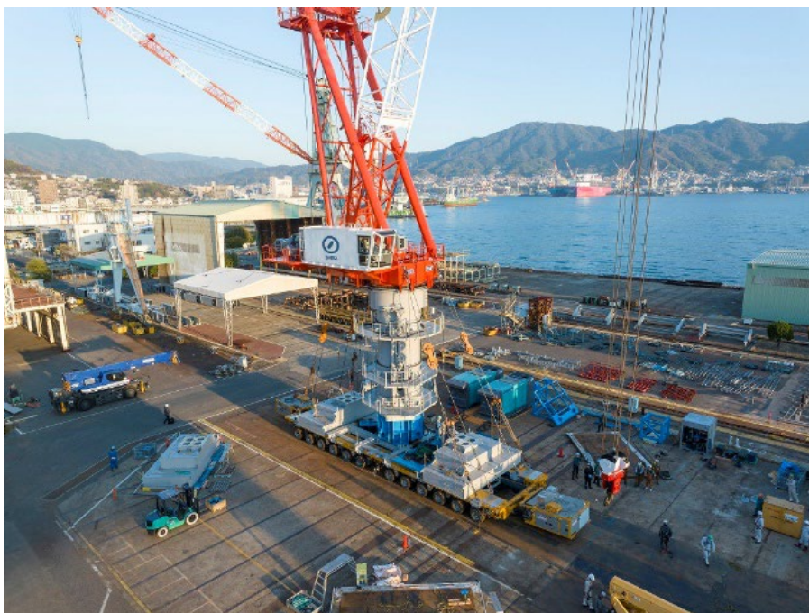
自走式多軸台車を用いたクレーン移送試験
