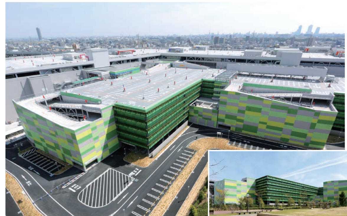
mozo ワンダーシティ立体駐車場棟（愛知県）
