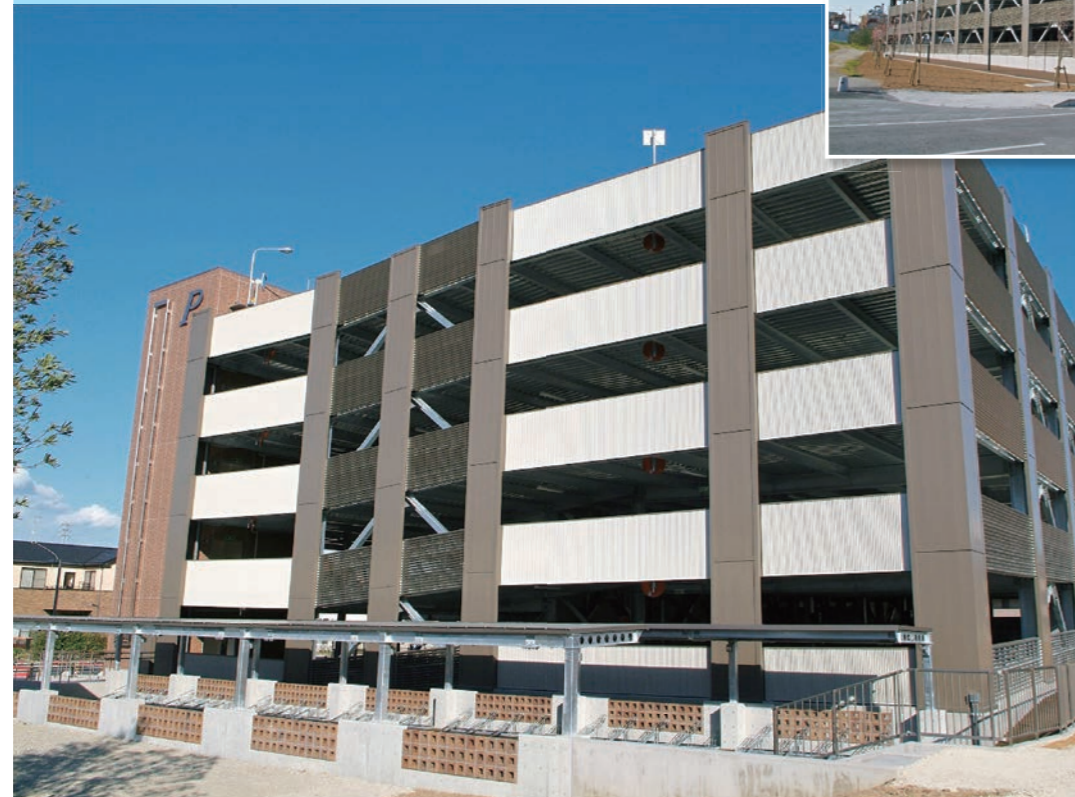
田原駅南公共駐車場（愛知県）
