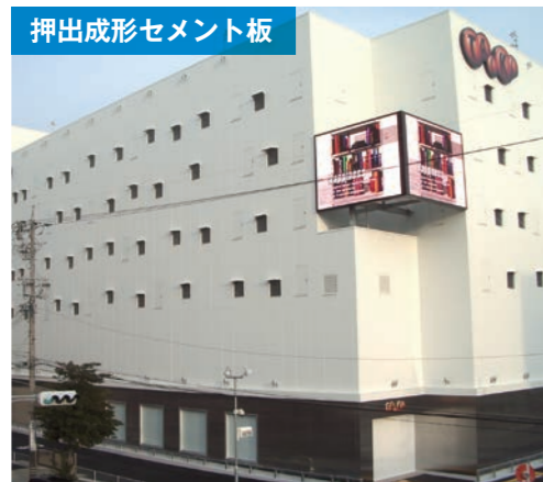
押出成形セメント板 +角波カラー鋼板
