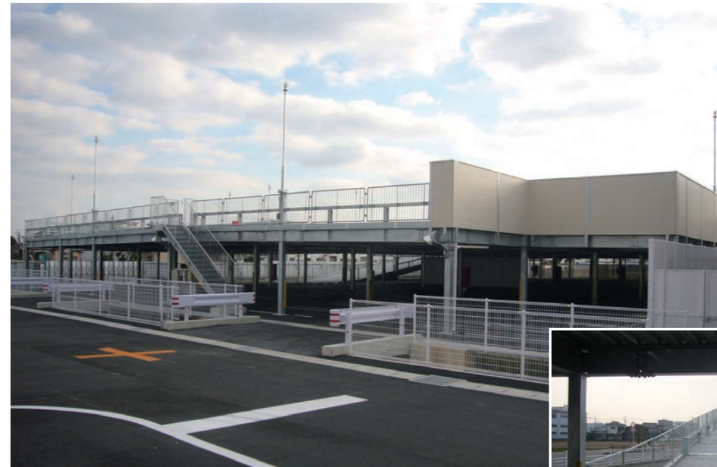
ダイナム福岡久留米店立体駐車場（福岡県）
