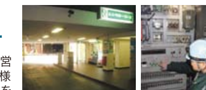
場内の設備機器の運営管理も承ります。専門技術者が点検・管理にあたります。
