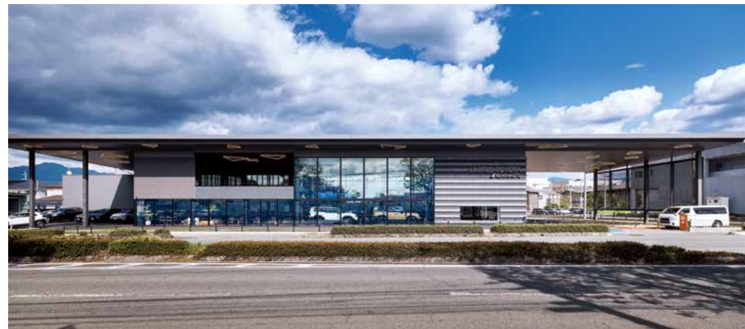
西側外観 溶岩石、カーテンウォールやタイルなど様々な素材を使用し、見る速度や角度によって表情を変えている
