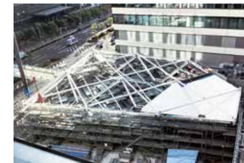
大屋根施工状況
