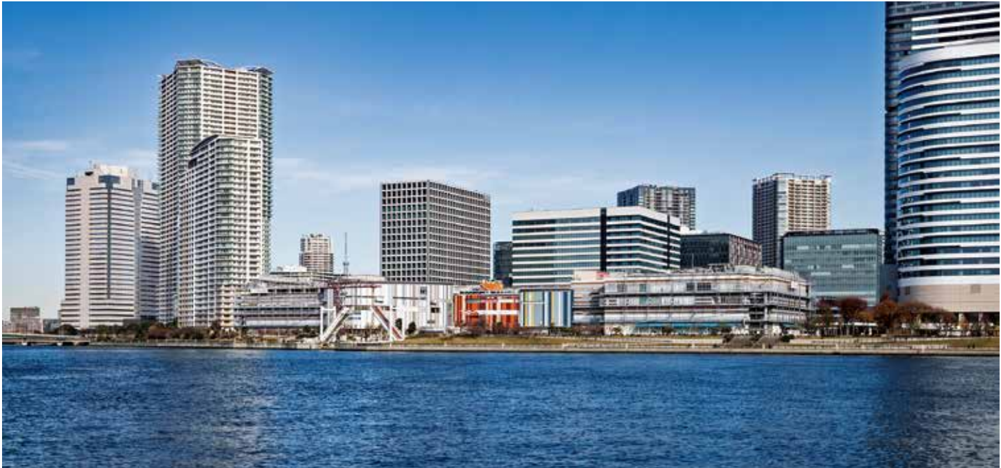
南側より外観を見る
