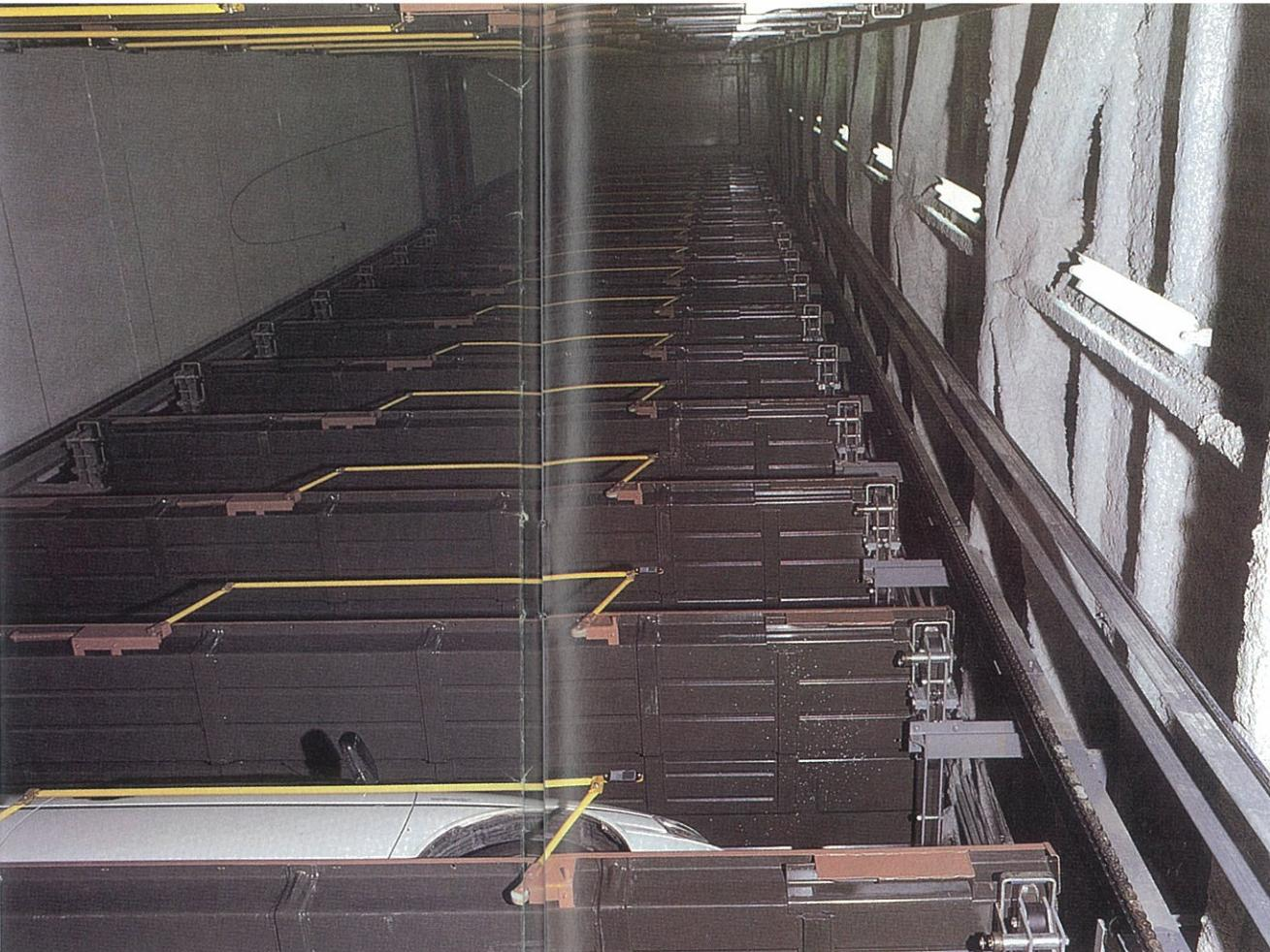
フリーローラの採用により水平移動だけで棚に格納できるため、収容効率は抜群である。
