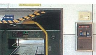
操作盤の上に設置されたインターフォンによって、PINセンターのサービスマンと直接会話ができる。
