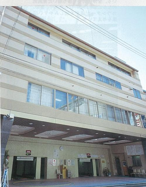
ヒロシマパーキング。料亭に隣接していること、前面に住宅部分を設けていることを配慮して、低騒音・低振動のエレベーターパーキングを導入した。
