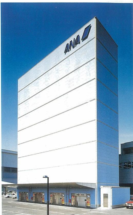
33台×4基、132台収容のタワーパーキング。海が近いので耐塩性能を考慮に入れて壁面はALC+アクリル+シリコン吹付タイルを使用。カラーで全日空を表現している。庇は飛行機の翼をイメージしたデザインである。
