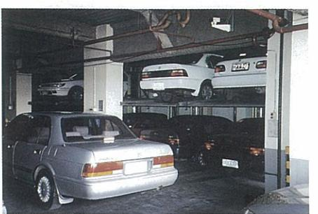
ビルに設置されたドイツ製2段式駐車装置。
