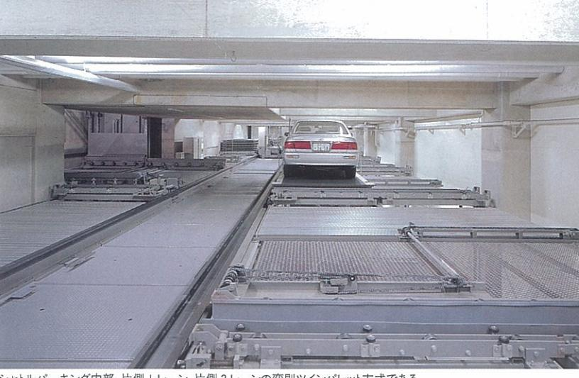
シャトルバーキング内部。片側1レーン、片側2レーンの変則ツインパレット方式である。
