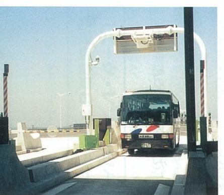
ETCの実験。車載機をつけたバスが通過すると自動的にゲートが閉鎖し、料金をチェック=東京湾アクアライン
