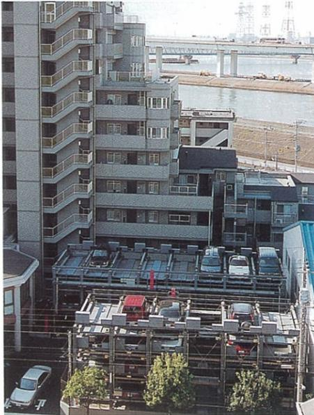
(上) 周囲のマンションに溶け込む模様のEP(写真中央=幕張のセントラルパーク・ウエスト) (左) 地上36m、地下27mのEP(横浜・上大岡のマンション) (右) マンションの敷地内に設置した4段昇降横行式駐車場
