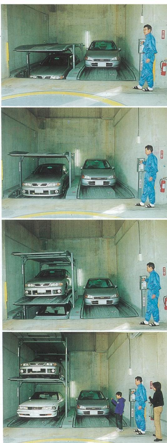
▲地下に収容するピット3段昇降式駐車場。簡単な操作で地下の車がせり上がってくる(横浜・上大岡のマンション)
