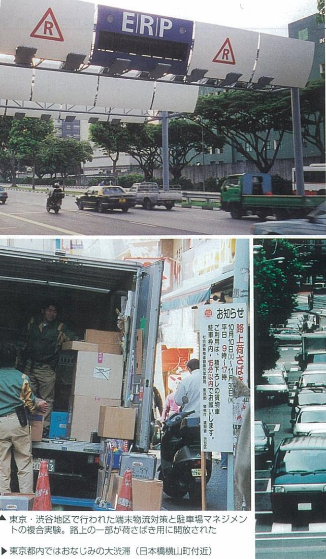
◀シンガポールのロードプライシング「ERP」のゲート。無人で、中央のコンピューターにより集中制御されている。（写真提供：高橋洋二・東京商船大学教授）
