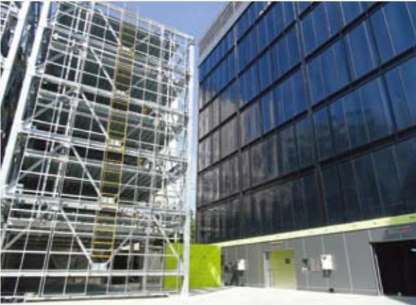
地上6段昇降横行式パークリング(左)とエレベータパークリング(右)
